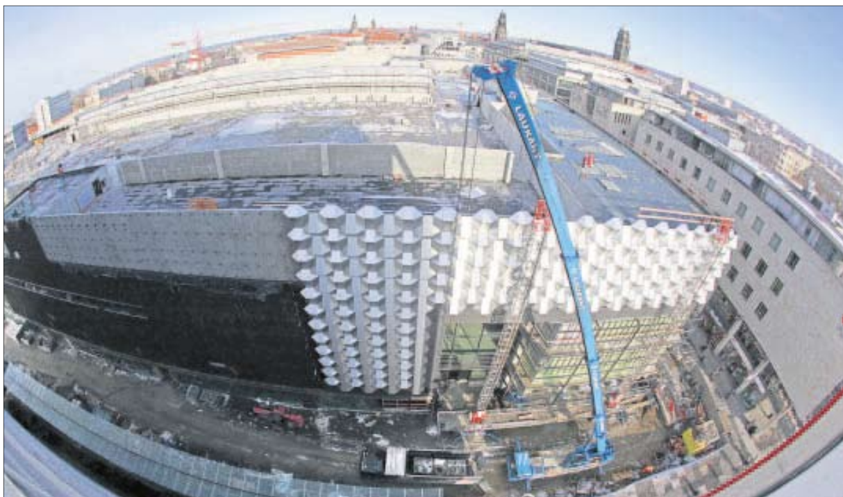
Dresdens größtes Bauprojekt ist derzeit die Centrum-Galerie. Das Einkaufszentrum entsteht bis zum Herbst 2009 an der Prager Straße. An die Fassade kommen Aluminiumwaben, wie sie einst das alte Centrum-Warenhaus an dieser Stelle geziert haben. Fotos: St. Füssel (3), Archiv
